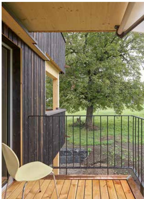
Das Ankothen der Oberfläche macht das Holz wasserabweisend, haltbar und widerstandsfähig gegen Insekten- und Pilzbefall.
